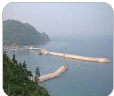
임원항 물량장 개축 및 선양장 축조 공사
