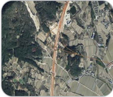
전주 광양간 북남원나들목 8공구
