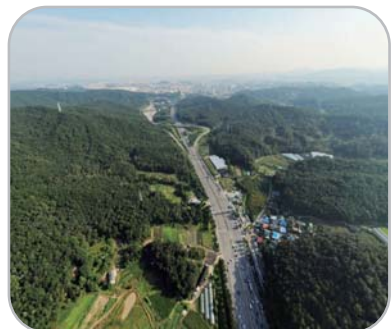
영동선 북수원나들목~동수원 나들목 부가차로 설치공사
